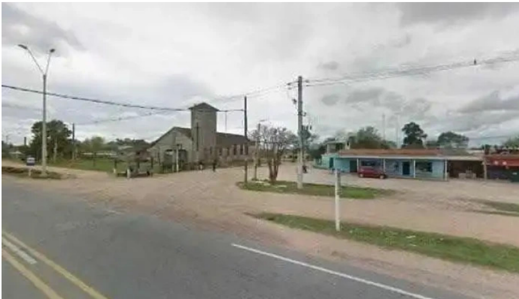
Autoservice la capilla street view y 360
