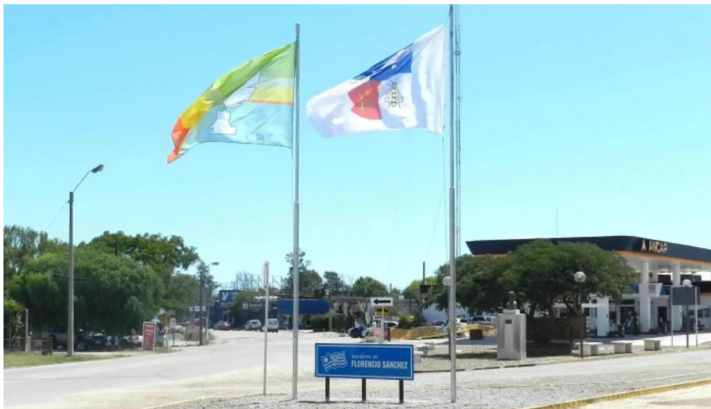
Municipio de florencio sanchez edificio
