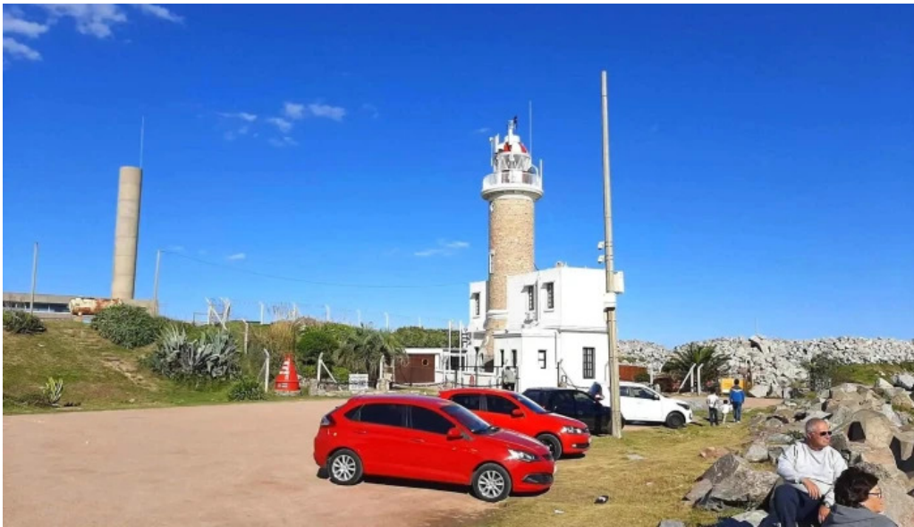
La estacada faro de punta carretas
