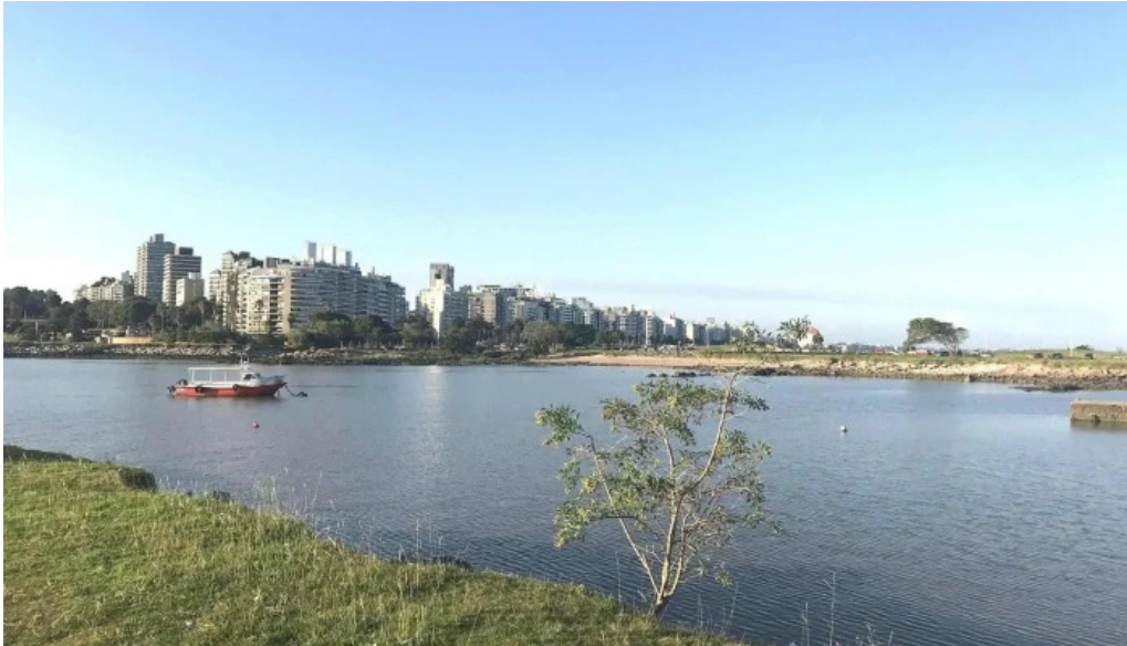
La estacada puerto deportivo de punta carretas
