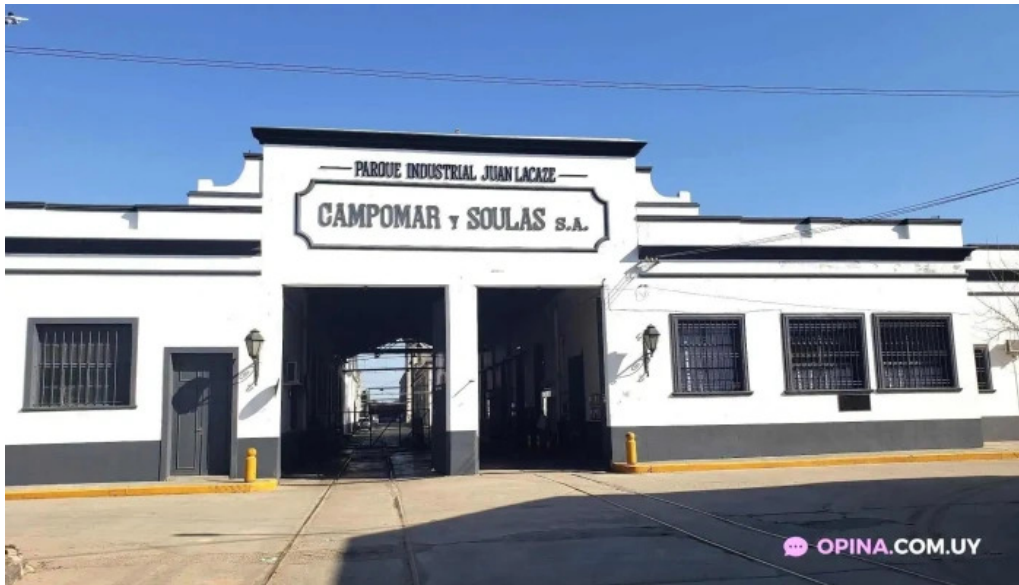
Parque industrial de juan lacaze exterior
