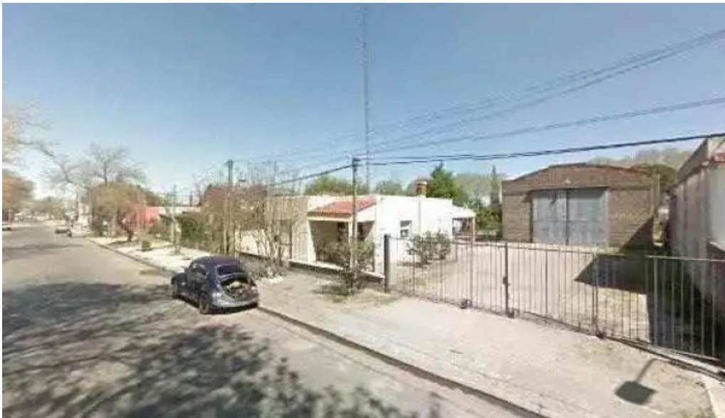
Casitas de piedra street view y 360
