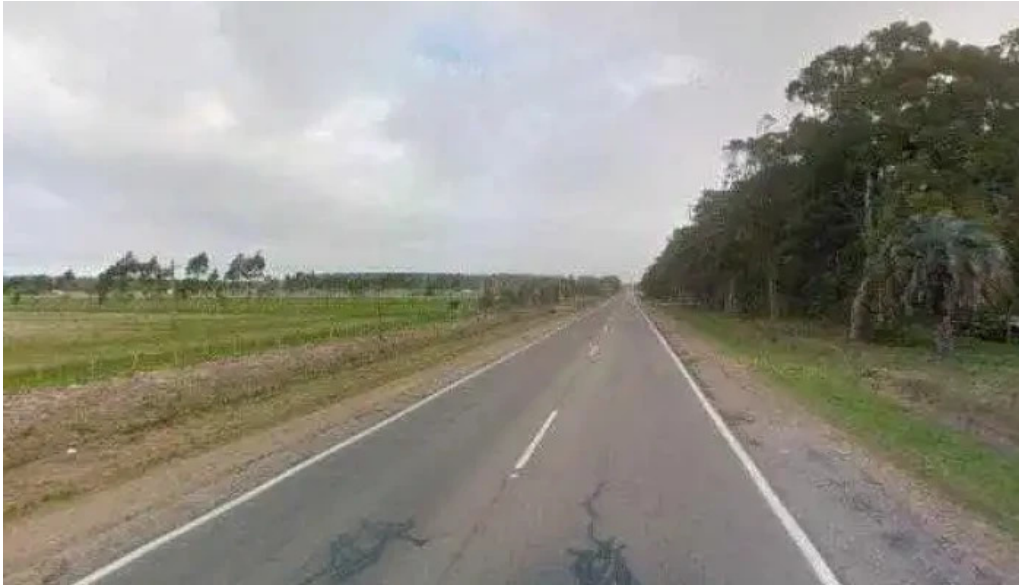
Posta de la laguna street view y 360
