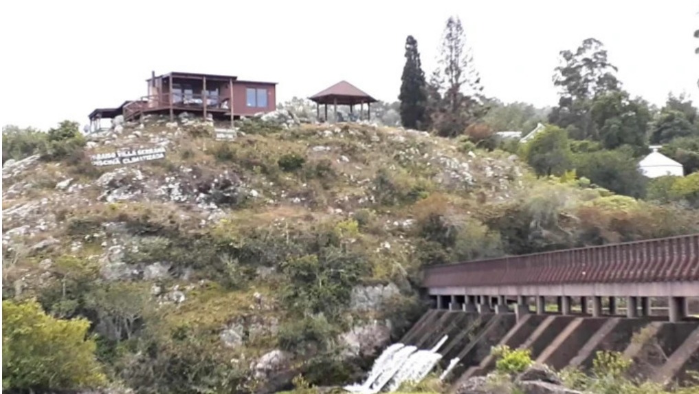
Posada itay exterior
