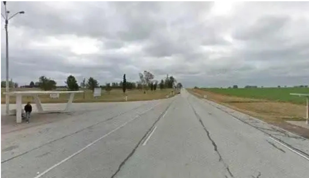
Empalme quebracho todo
