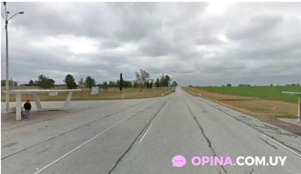
Empalme quebracho quebracho
