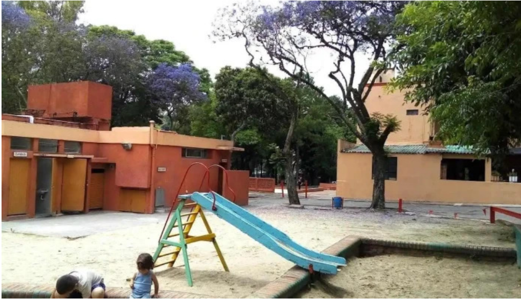
Centro proteccion choferes de monteideo monteideo
