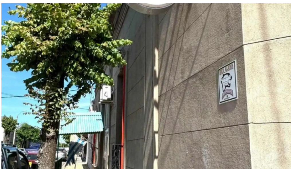
Centro de educacion inicial rincon de luz del propietario
