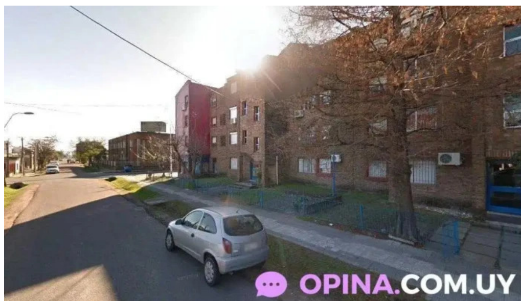
Viviendas bhu las piedras
