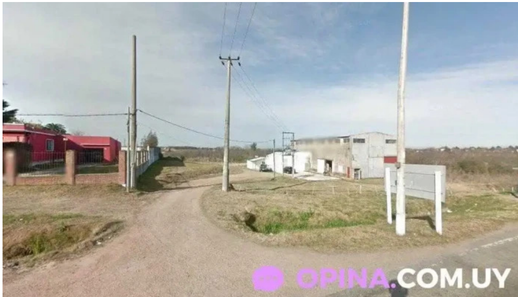
Casa de rehabilitacion Barros Blancos
