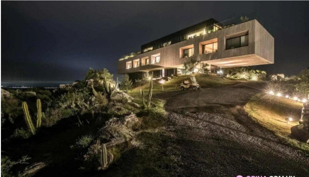
Hotel fasano punta del este exterior
