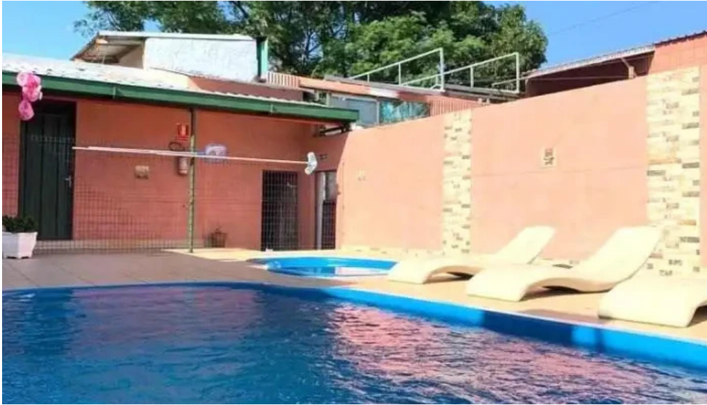
Posada la casona exterior
