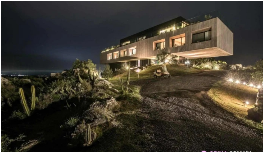
Hotel fasano punta del este exterior
