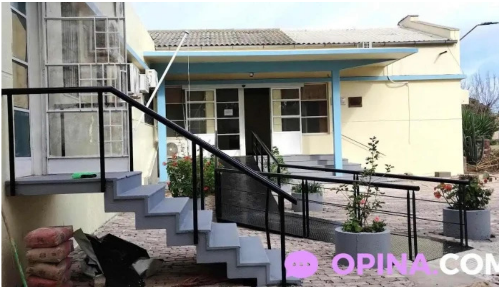
Centro auxiliar nueva palmira nueva palmira
