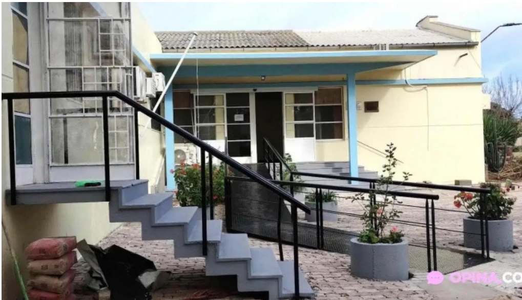
Centro auxiliar nueva palmira nueva palmira
