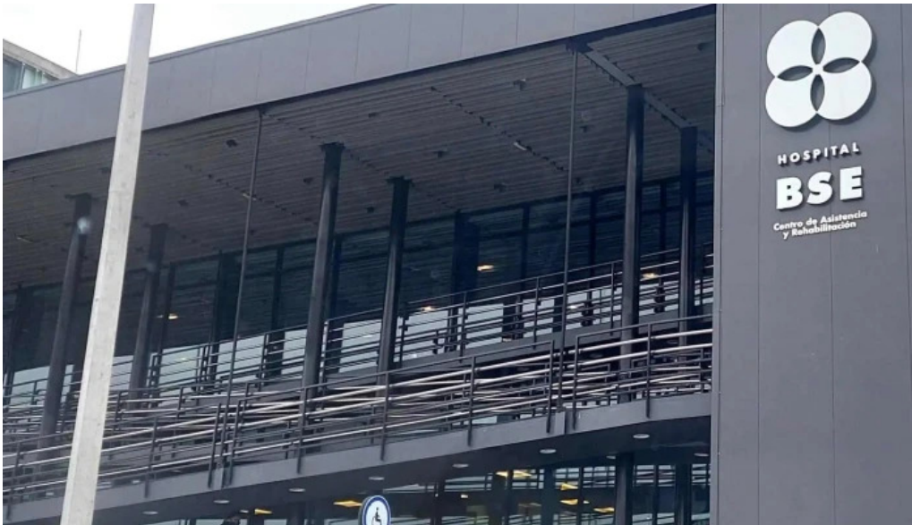
Banco de seguros del estado hospital comentario 2
