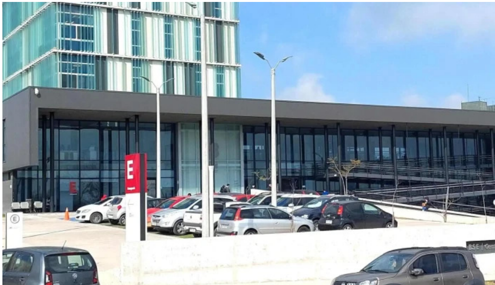
Banco de seguros del estado hospital comentario 5
