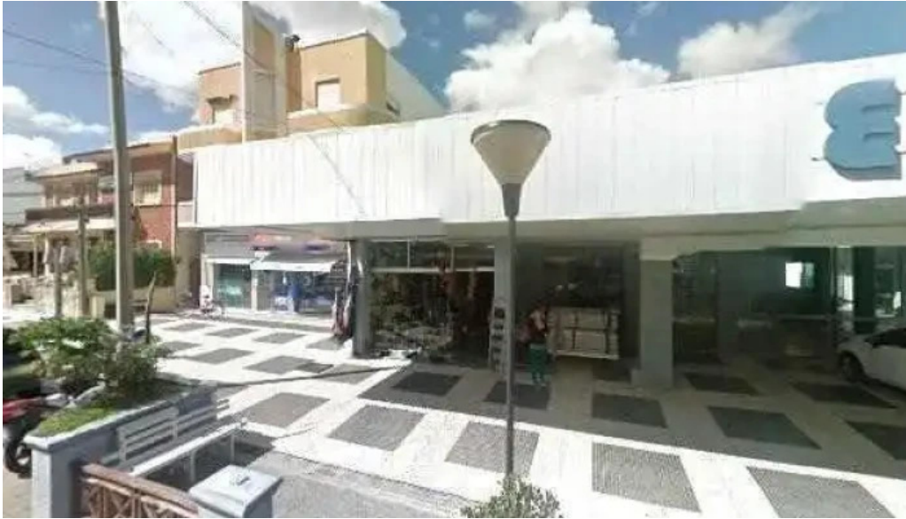
El faro street view y 360
