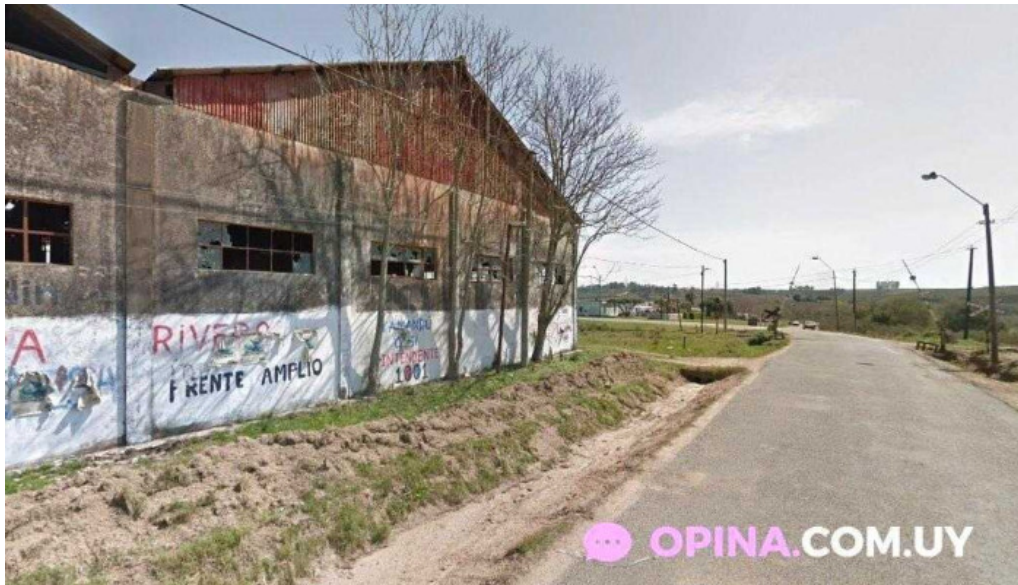
Polideportivo empalme olmos empalme olmos
