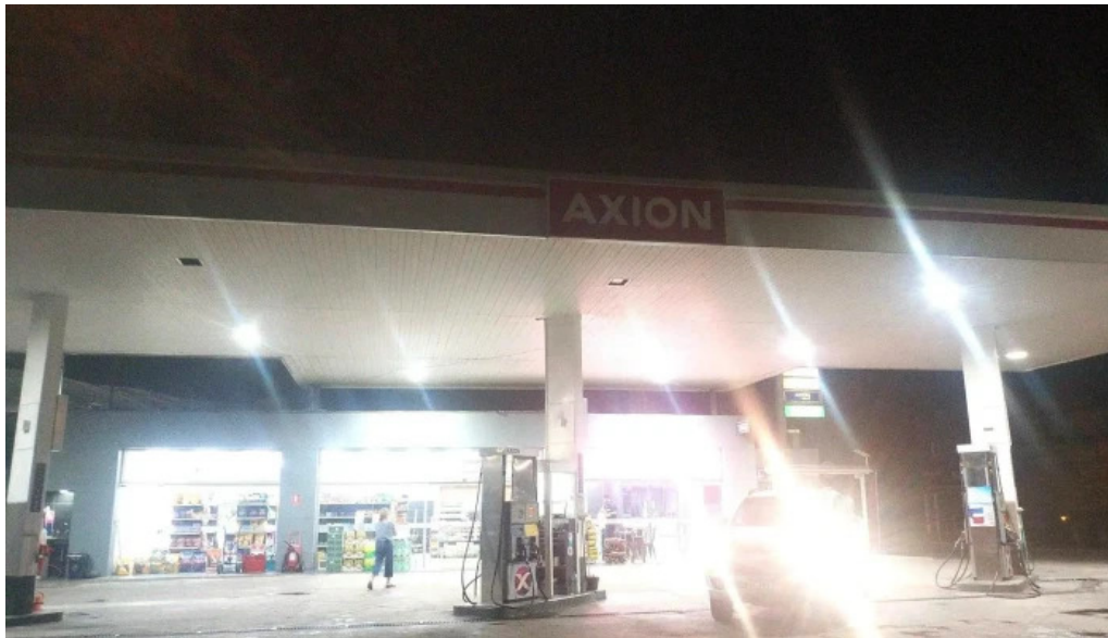
Axion ruta 12 estacion de servicio
