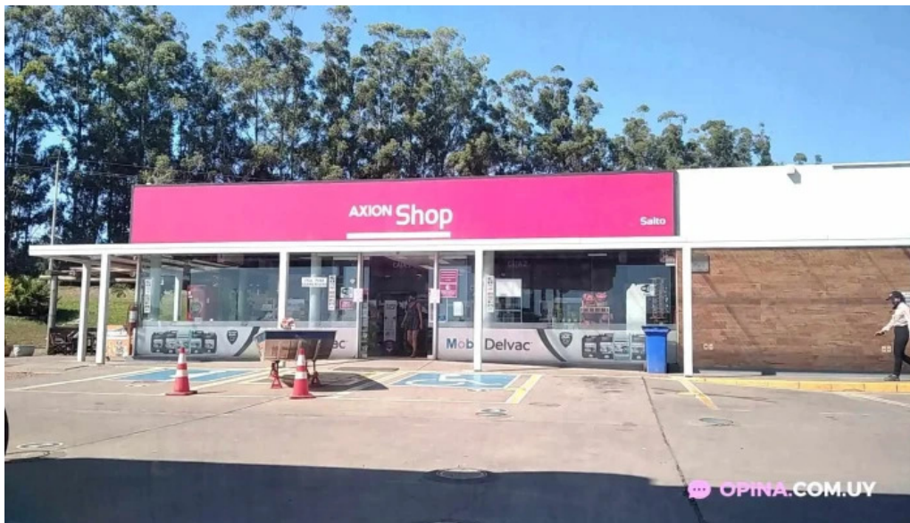
Estacion axion salto exterior
