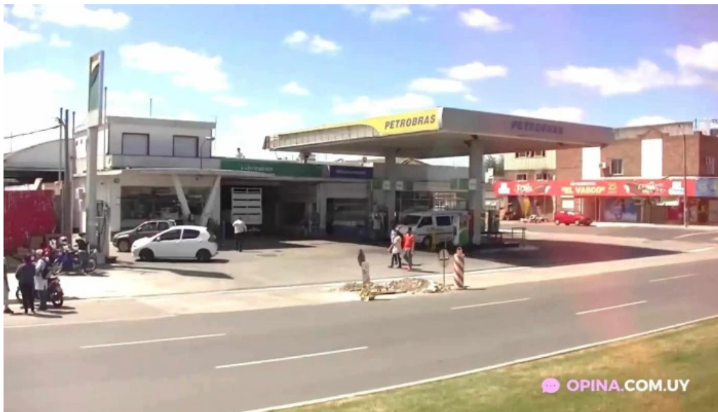
Disa surtidor de combustible
