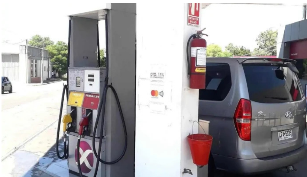
Axion energy estacion de servicio
