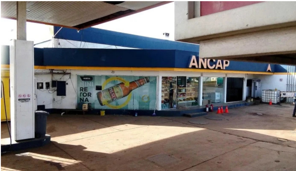
Estacion ancap exterior
