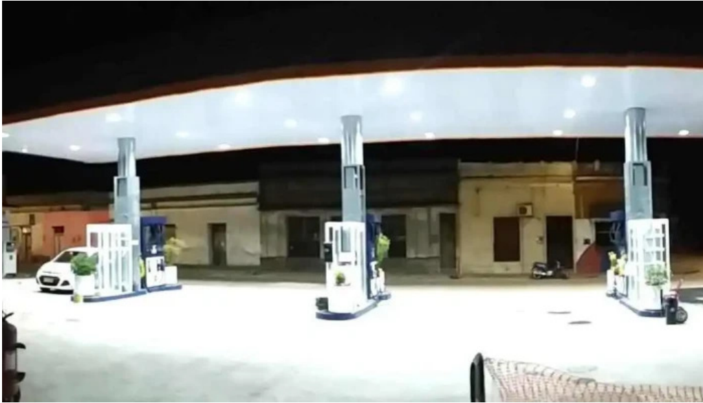
Ancap surtidor de combustible
