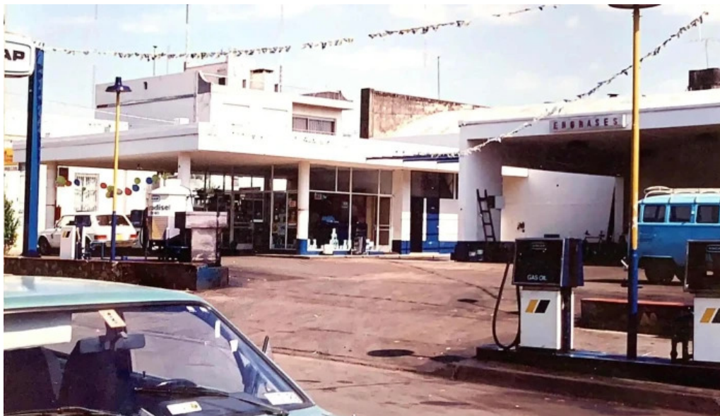
Ancap surtidor de combustible
