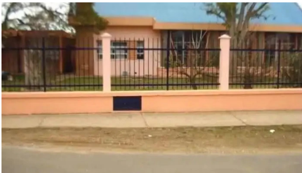
Escuela no 72 exterior
