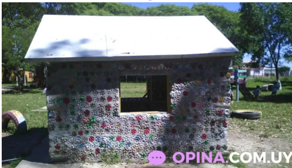
Escuela especial n°223 progreso
