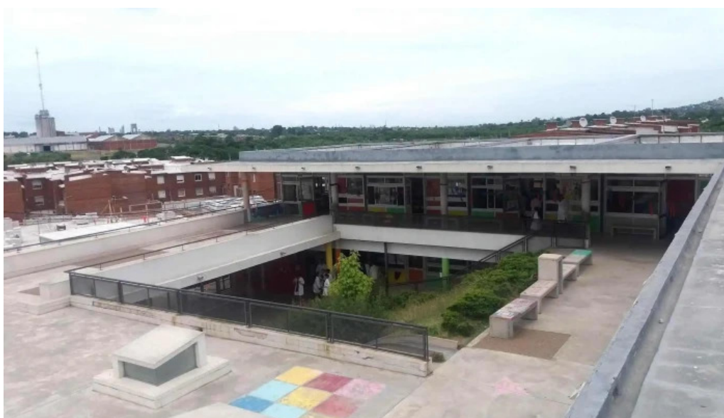
Escuela tiempo completo 384 edificio
