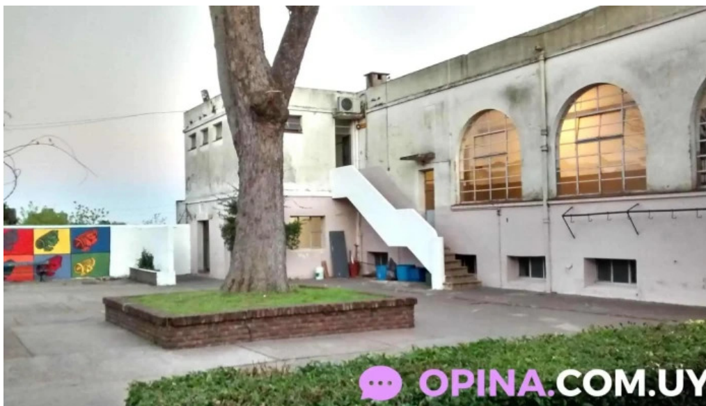
Escuela tecnica superior pedro blanes viale edificio
