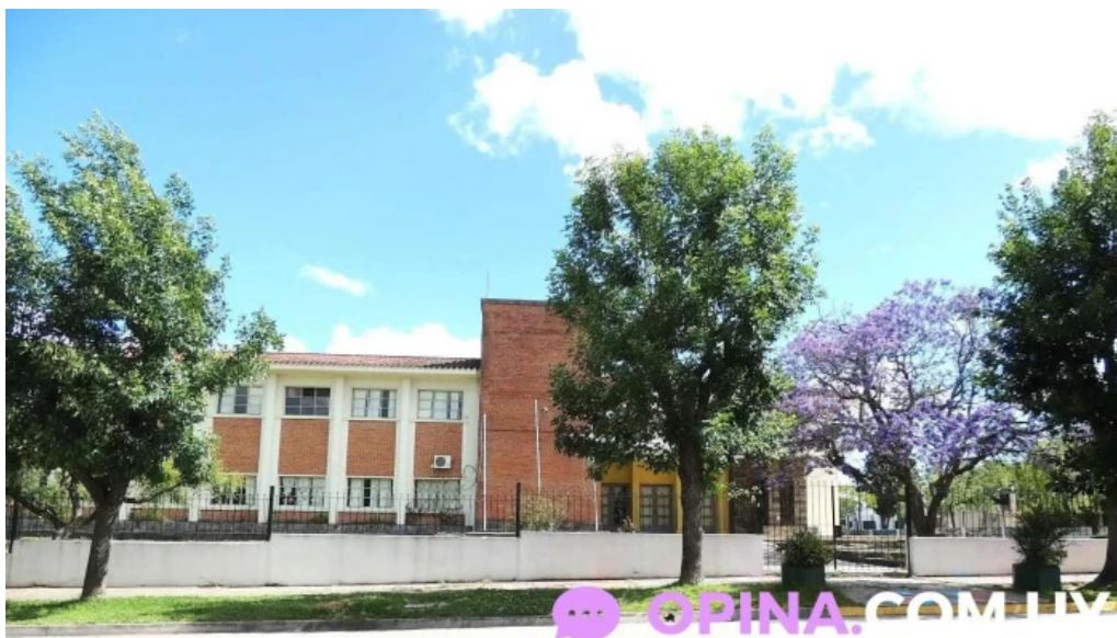
Escuela varela amelia edificio
