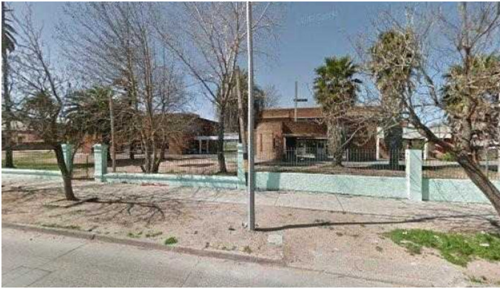
Escuela no 361 federacion rusa ubicaciondeg
