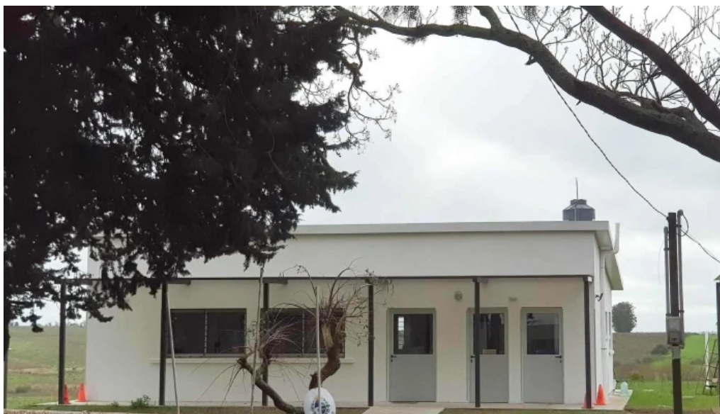
Escuela no 88 las piedritas descuentos
