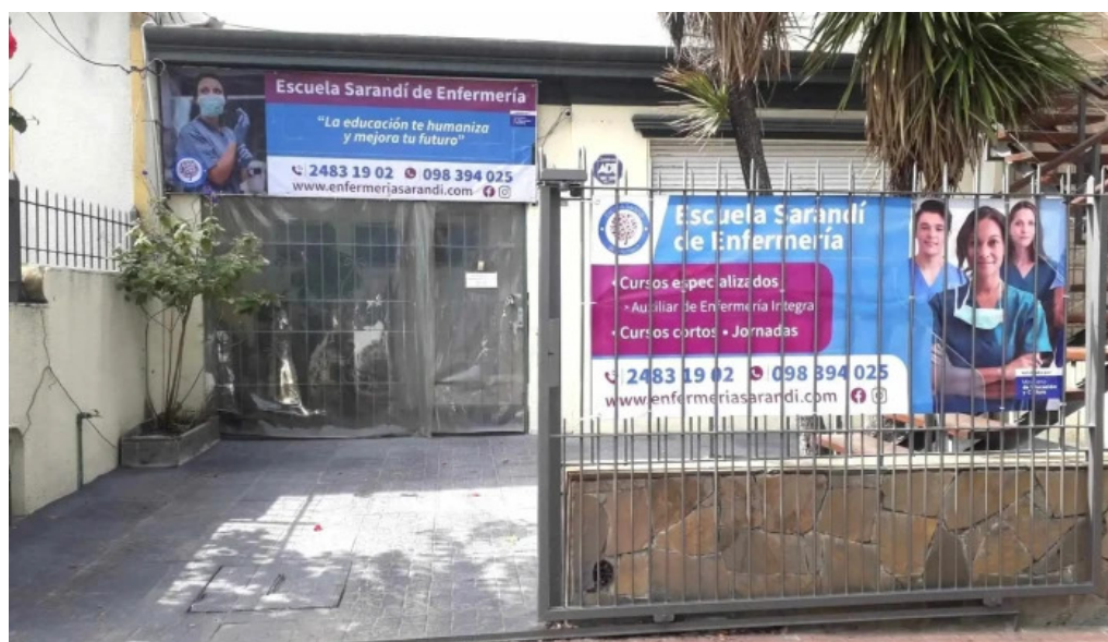
Escuela sarandi de enfermeria edificio
