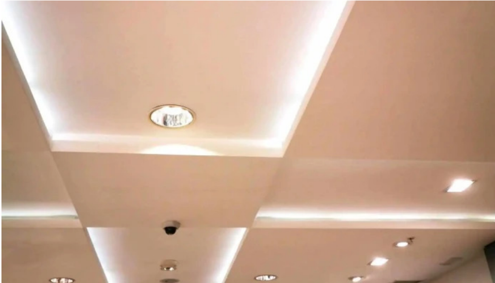
Epc instalaciones y montajes electricos del propietario
