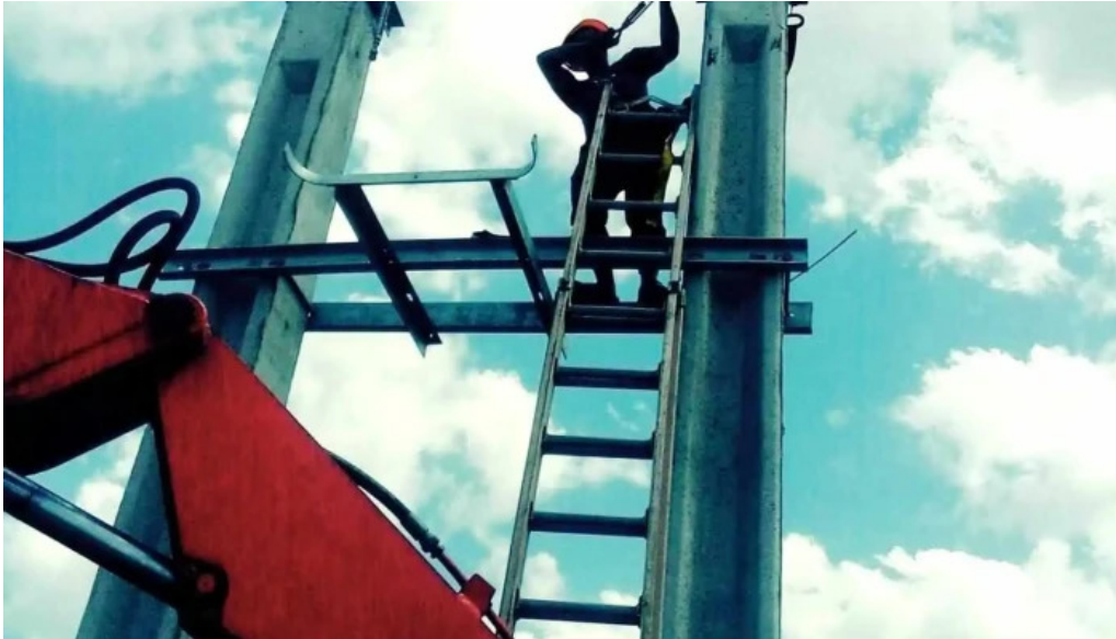
Electricistas unidos electricista
