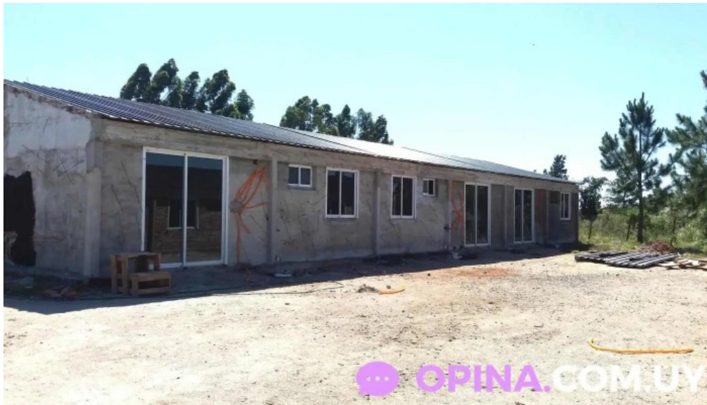
Viviendas covideco 1 exterior
