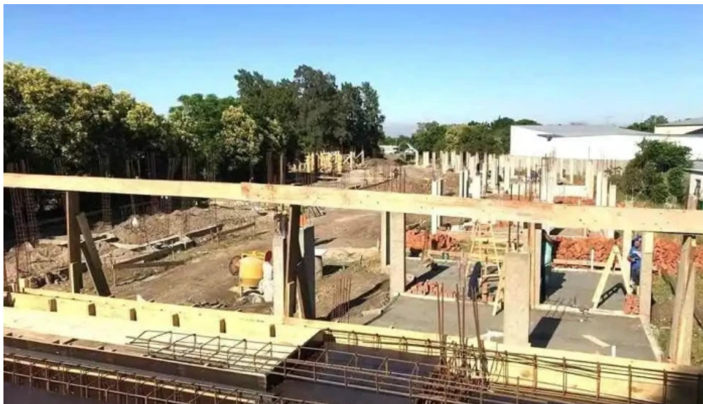
Vivienda covifusap exterior
