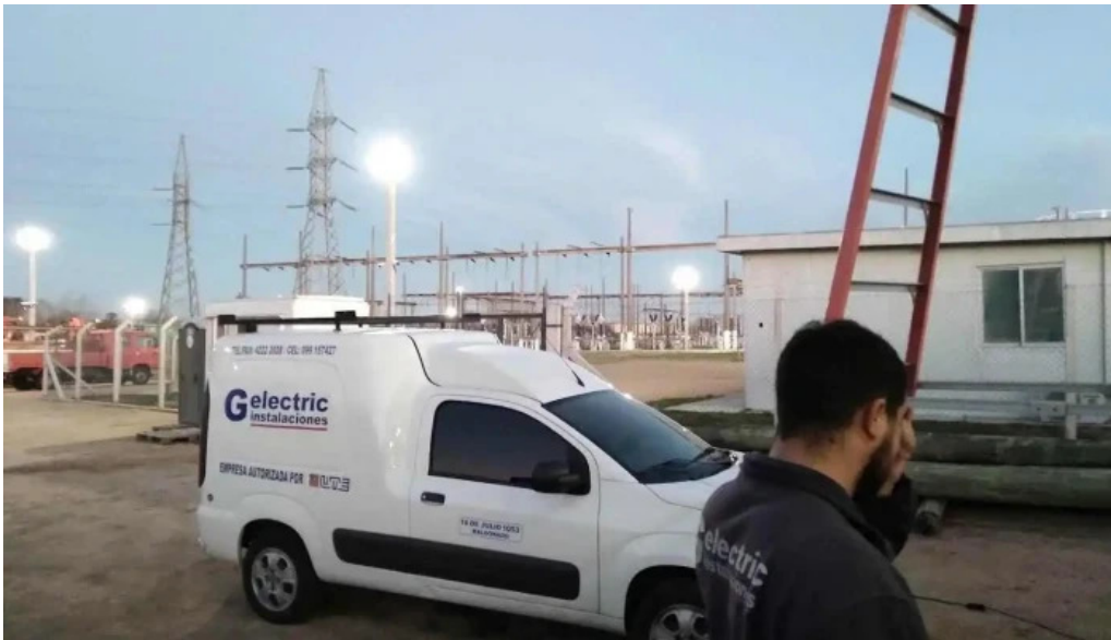
Gelectric instalaciones maldonado
