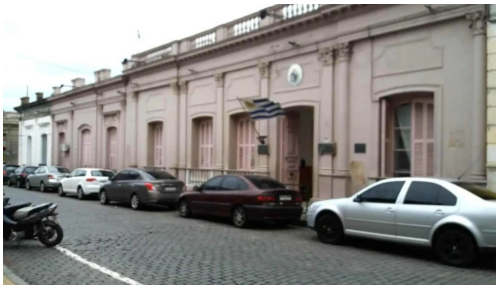
Escuela nro 4 jose artigas edificio
