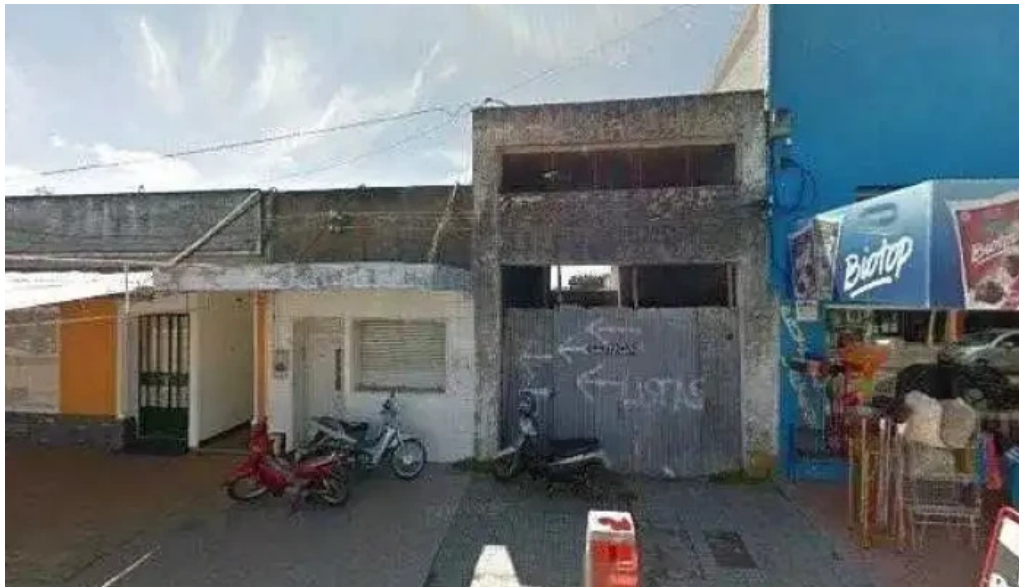
Centro comercial de tala street view y 360
